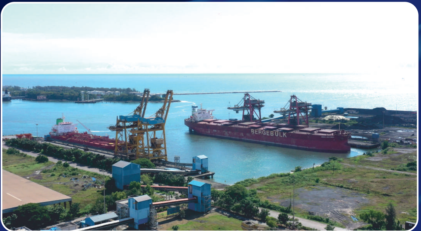
मशीनीकृत कोयला हैंडलिंग Mechanized Coal handling
